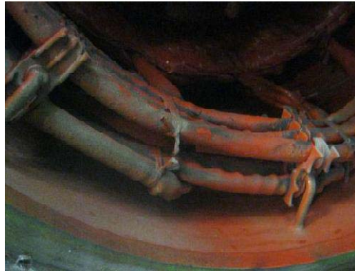
Ablagerungen und Korrosion im Geno
