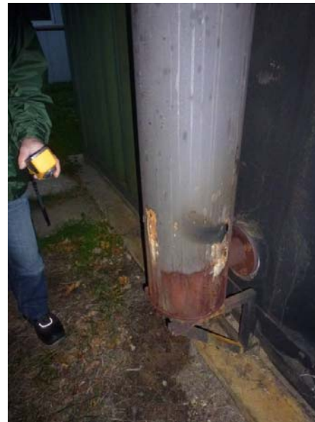
durchgerosteter Abgaskamin
