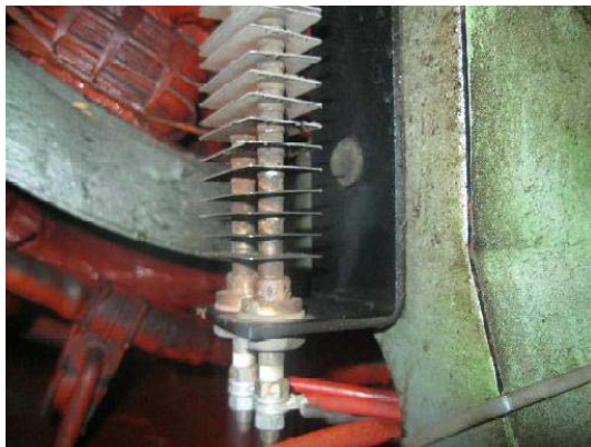
Korrosion und Salzablagerungen
